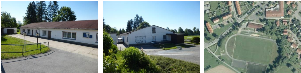
Sportlerheim, schlechter baulicher Zustand Pirnaer Landstraße 3
