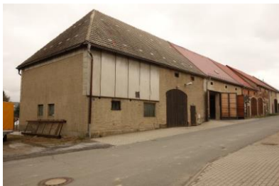
Bauhof, Aufenthaltsraum und Lager
