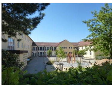
Grundschul- und Oberschulstandort
