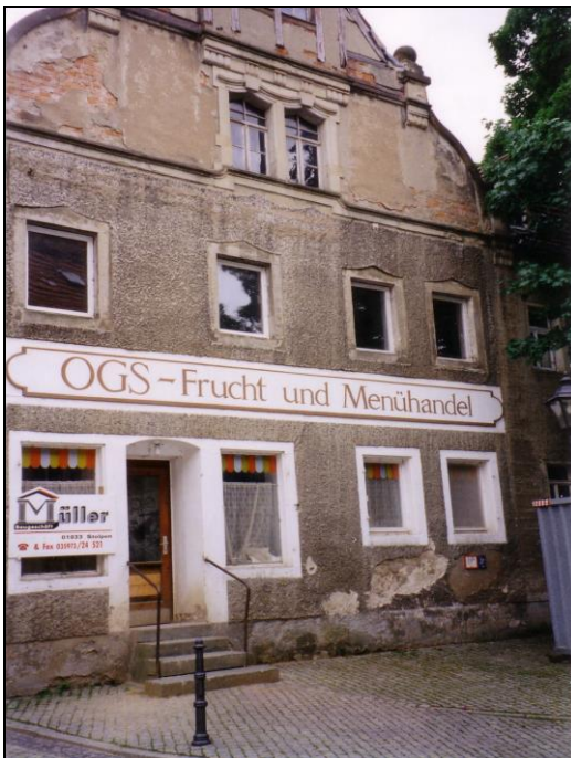
Alte Schulstraße 21 vor der Sanierung
