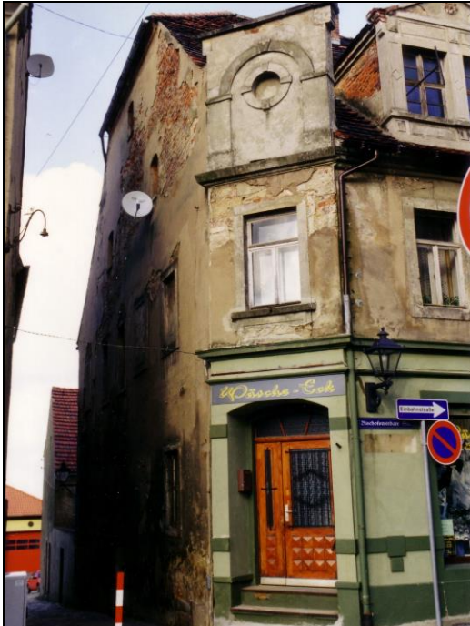
Bischofswerdaer Straße 1 vor der Sanierung
