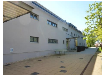
Turnhalle der Grund- und Oberschule
